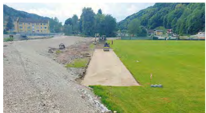
Bauarbeiten am Sportplatz
